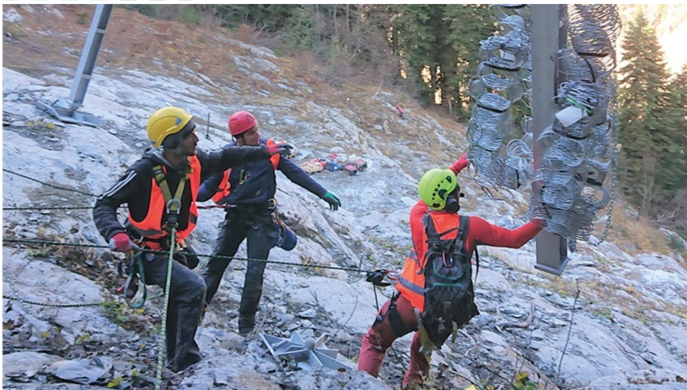
Heli-Montage der Lawinerverbauung TS-LV aus Salzburg im russischen Kaukasus Gebirge.
